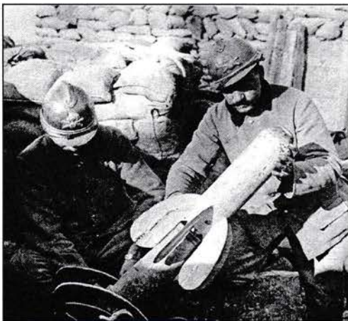
Un « crapouillot » : mortier de tranchée de 58 mm Poids : 16 kg - Portée : 600 m
